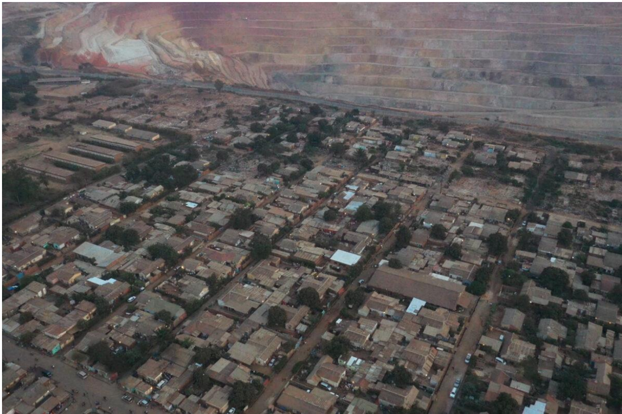
La vie, près de la carrière minière est rythmée par des perturbations environnementales permanentes : poussière, tremblement de terre à chaque minage et effondrement ou fissurations des murs. Image de Eric Cibamba.
